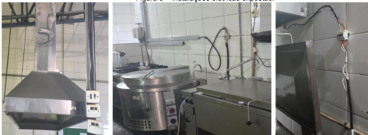
Figura 3 – Instalações elétricas expostas.
